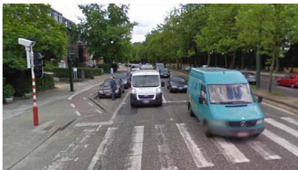
Boulevard Lambermont : Piste cyclable séparée avec réinsertion dans les carrefours tardive (ne permettant pas le placement aisé dans le SAS ) et masquée (risque de conflit avec les automobilistes qui tournent à droite)
